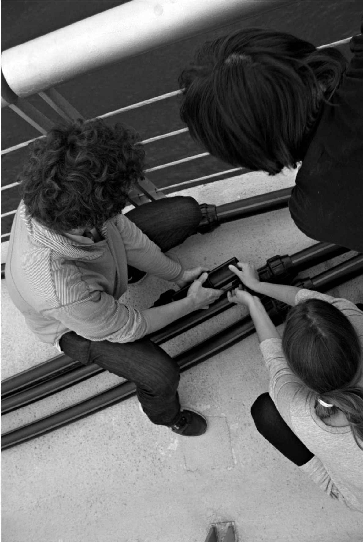
Conexión de tubos de polietileno
