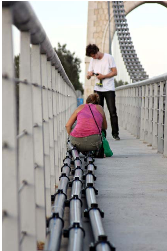
Montaje de collarines de PVC
