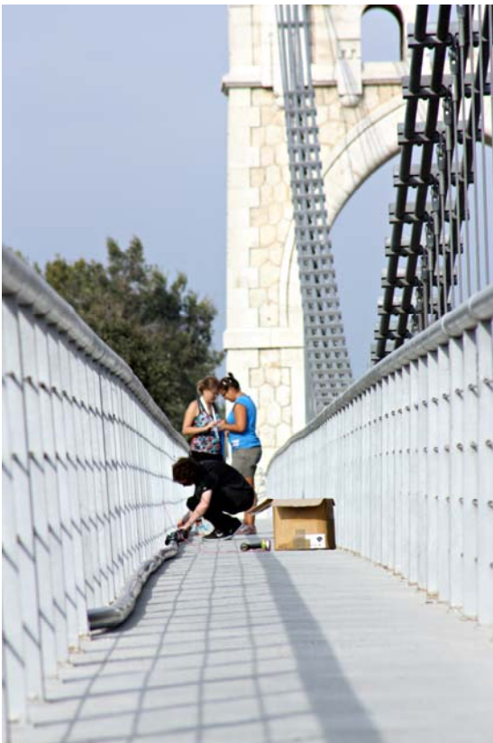
Montaje primer ramal
